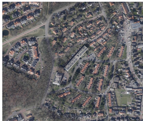
Afbeelding 31: Flatgebouw in het midden van de luchtfoto met de sensor aan de noord-west zijde. Luchtfoto van PDOK ( https://app.pdok.nl/viewer/ )
